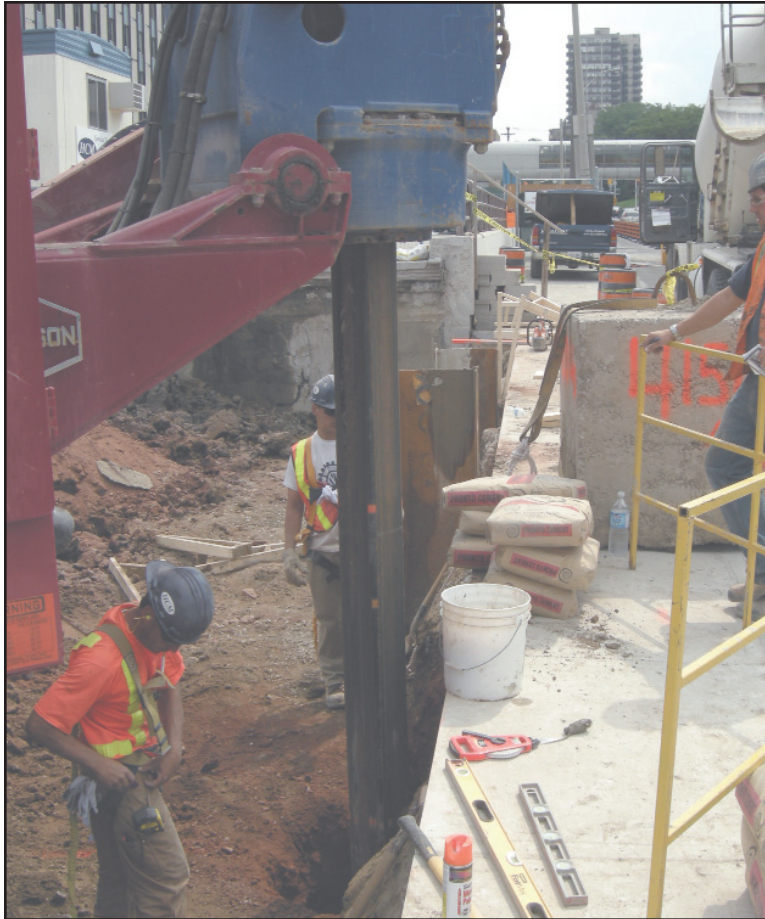
Photo courtesy: Andy van Oosterhout, Site Superintendent, PCL Construction
